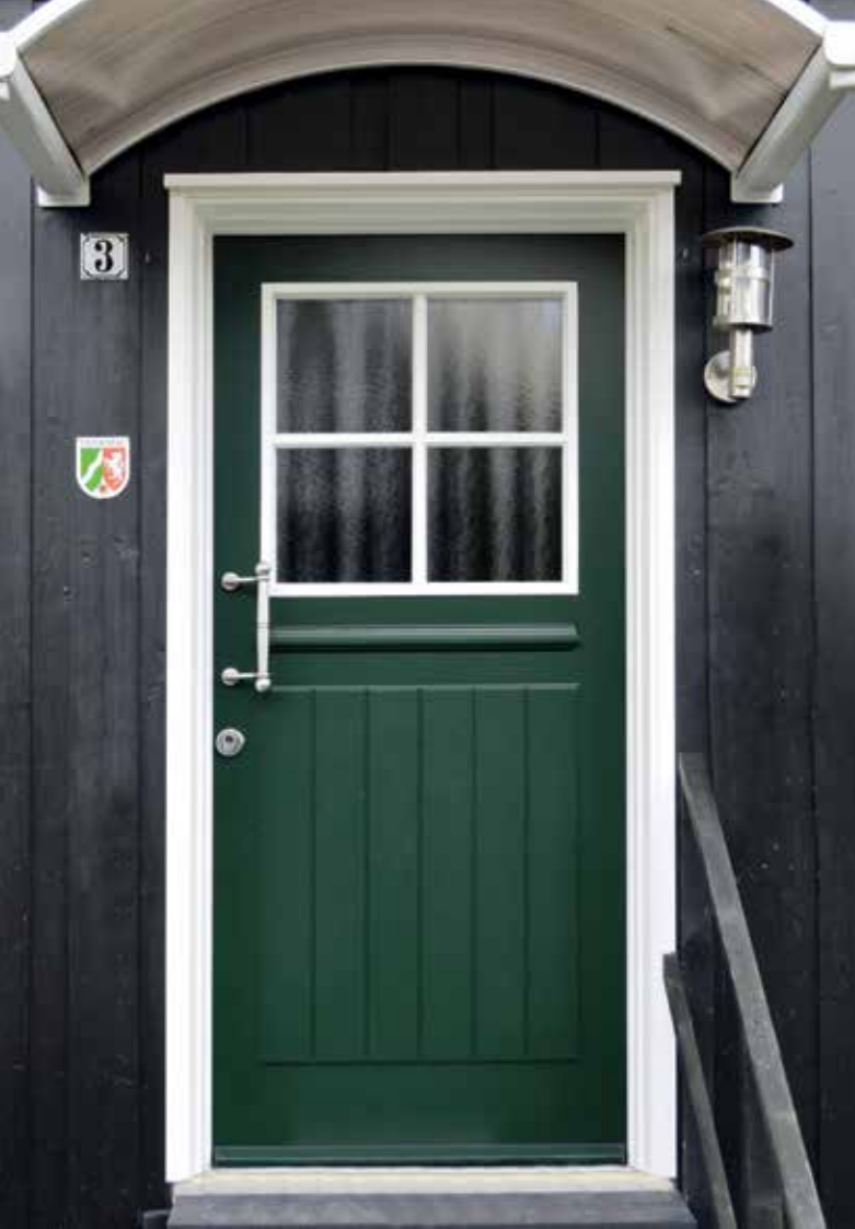
Zweifarbige gestaltete einflügelige Haustür mit Lichtausschnitt und abgesetztem Außenfutter
