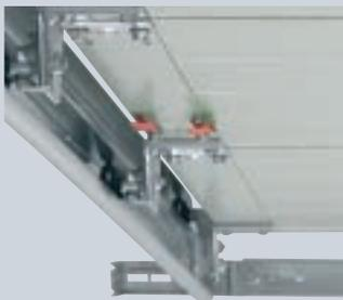
**Gesicherte Torführung in Sicherheits-Laufschienen**
